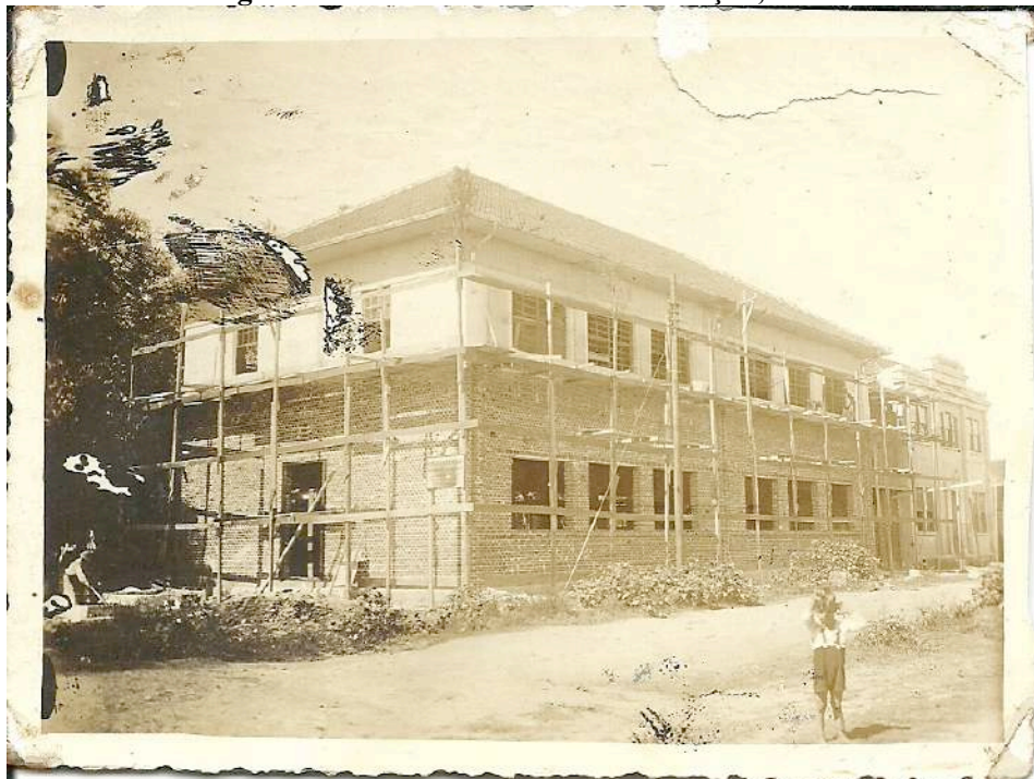
Figura 2 – Prédio escolar em construção, 1935.
