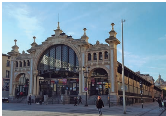
Figura 6. Mercado Central de Zaragoza
