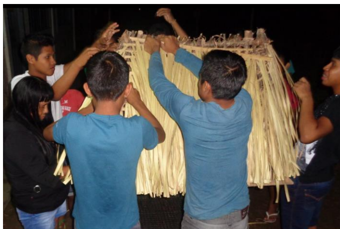
Figura 2. Construção do telhado da maloca.
