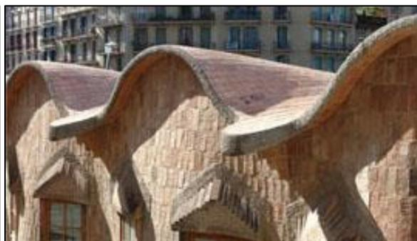
**Figura 04 – Parabolóide hiperbólico (Gaudi)**
