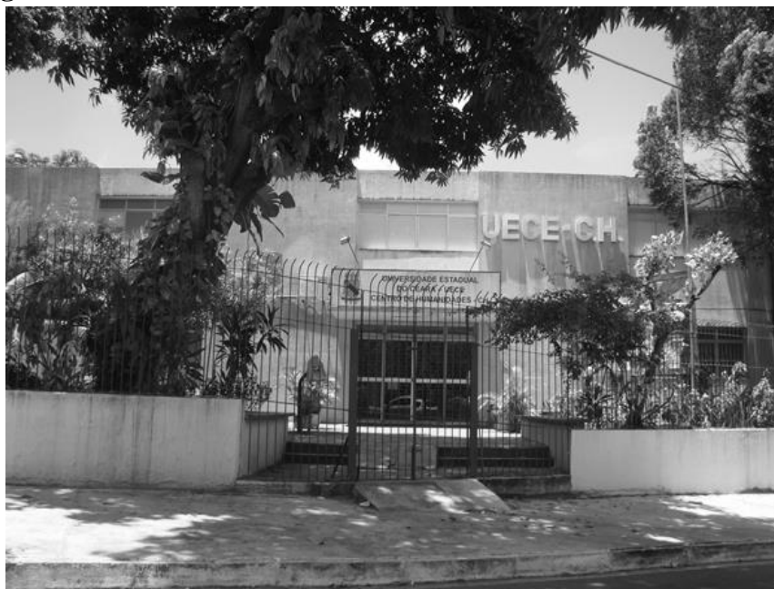
Figura 01 – Centro de Humanidades da Avenida Luciano Carneiro, s/d.
