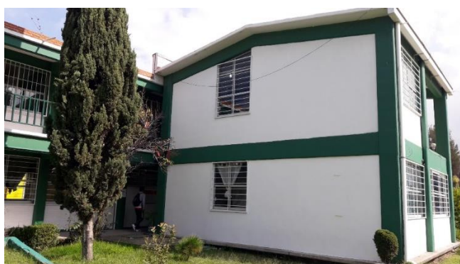
Figura 2. Edificio utilizado para el estudio.
