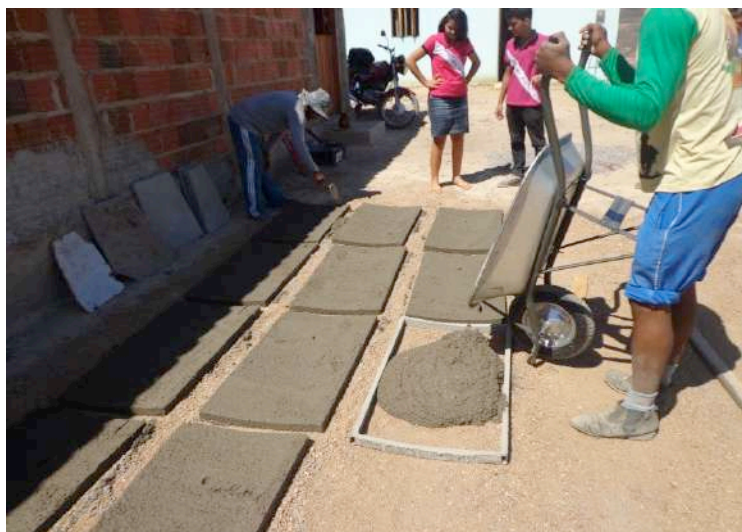
Figura 5 – Processo de confecção das placas da cisterna.
