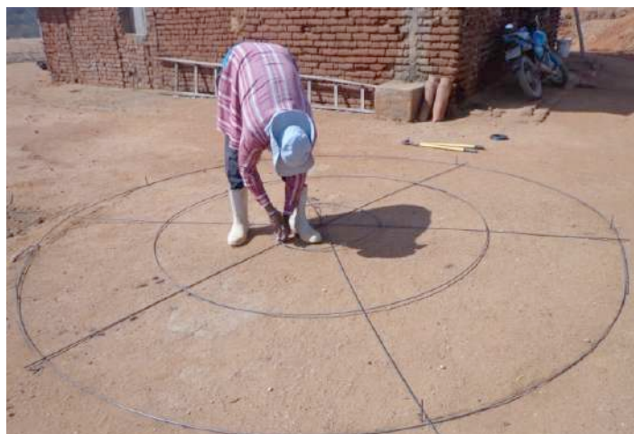
Figura 7 – Rodão do piso.
