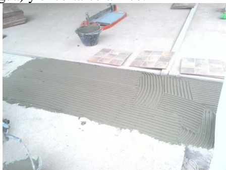
Ilustración 6. Reglas en escuadra y pegamento extendido sobre el piso
