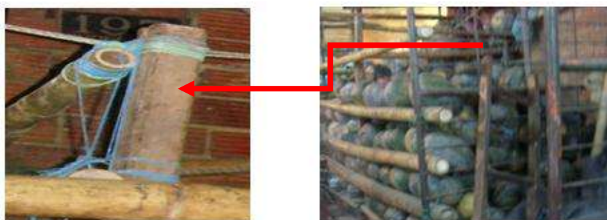
Figura 2. Manera como refuerzan los palos de Guaduas para darle resistencia. Además se puede observar el encajamiento de las ayamas de manera simétrica.
