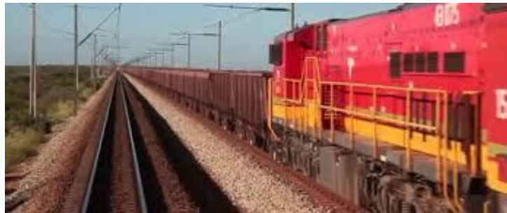
Figura 2. Vista de un tramo recto de vías.
