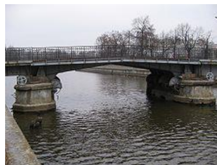
Puente de la Miel sobre el río Pregolia en Kaliningrado .
