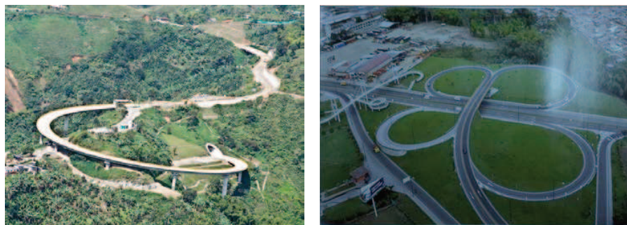
Figura 5. Puentes Helicoidal e Intersección a desnivel La Romelia
