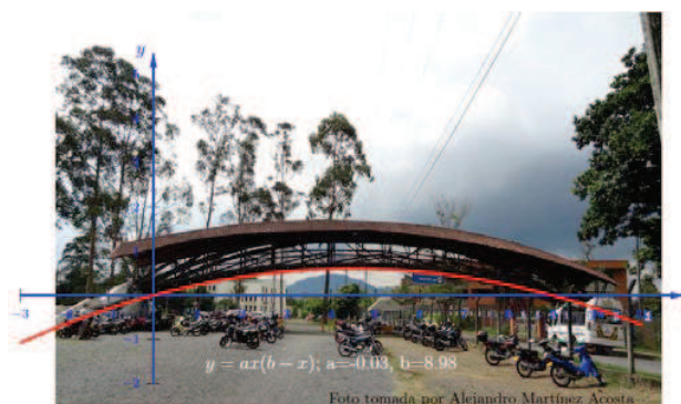
Figura 4. Guaducto de la UTP
