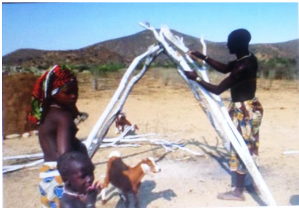
Figura 12. Construção da casa
