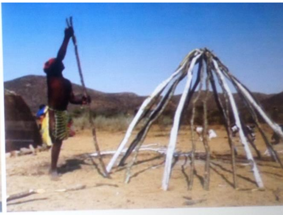
Figura 13. Construção da casa
