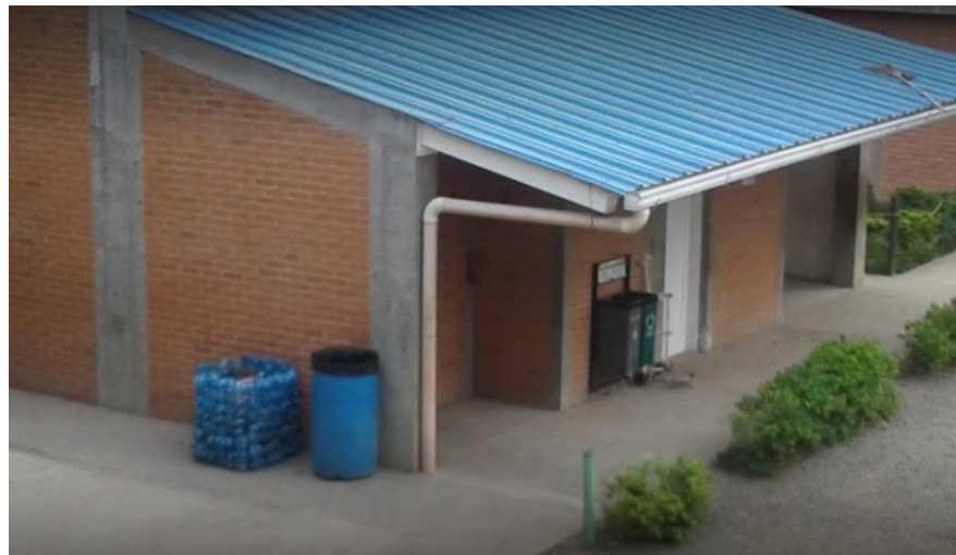
Figura 18 Zona de baños
