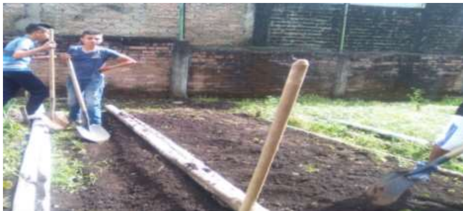
Ilustración 2: Construcción de eras
