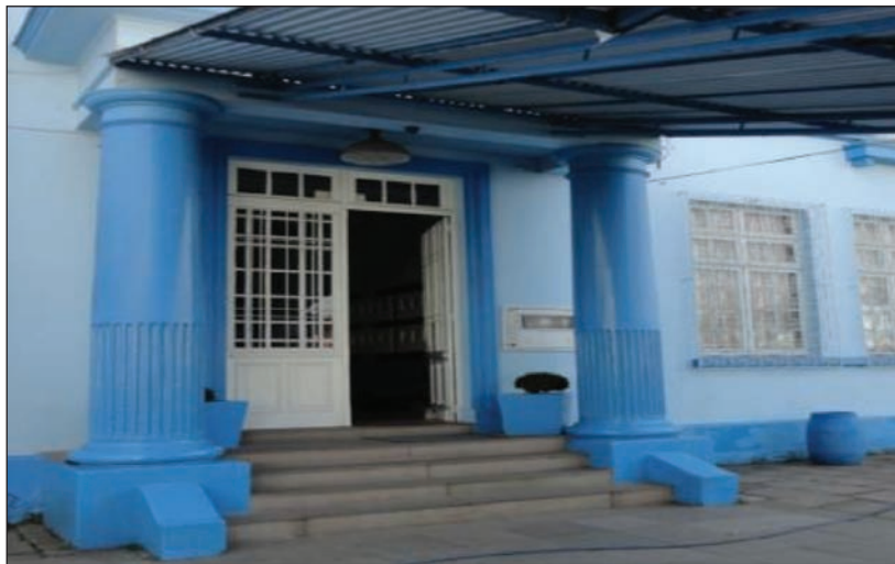
Figura 12 – Colunas do prédio principal da escola.
