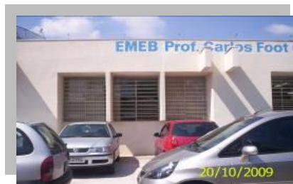
Foto 5. Fachada da escola
